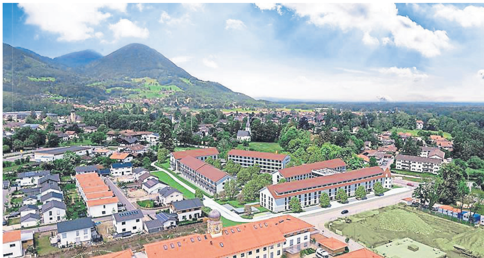
Die letzte Bauetappe: Auf dem 1,5 Hektar großen Sondergebiet entstehen gerade ein Pflegeheim, Betreutes und Sozialtherapeutisches Wohnen sowie 32 Wohnungen mit einkommensorientierter Förderung. So wie in der Grafik soll das Dorf im Jahr 2022 aussehen. FOTOS: INNTAL BAU GMBH/SCHLECKER
