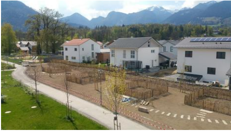
Außenanlagen sind nahezu fertig!
